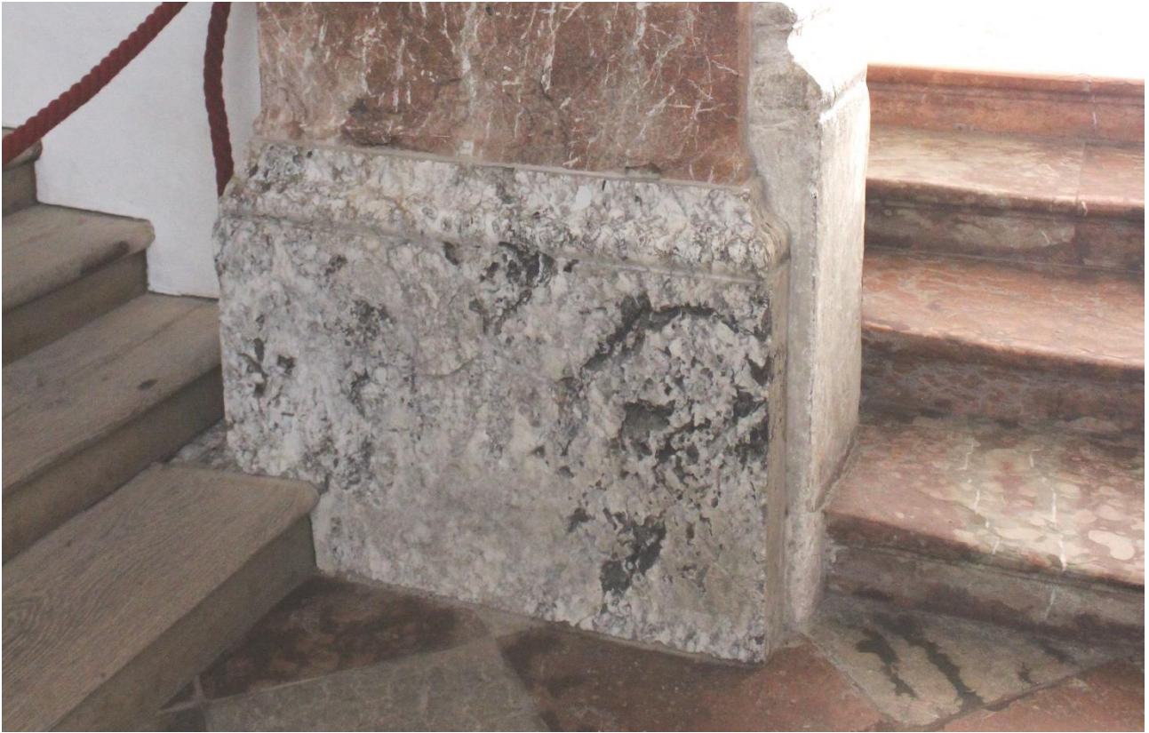
Abb. 22: Pilastersockel aus brekziösem weiß-schwarzem Kalkstein, Bildbreite ca. 150 cm (aufgenommen im Freisinger Dom: Durchgang zur Vorhalle).
