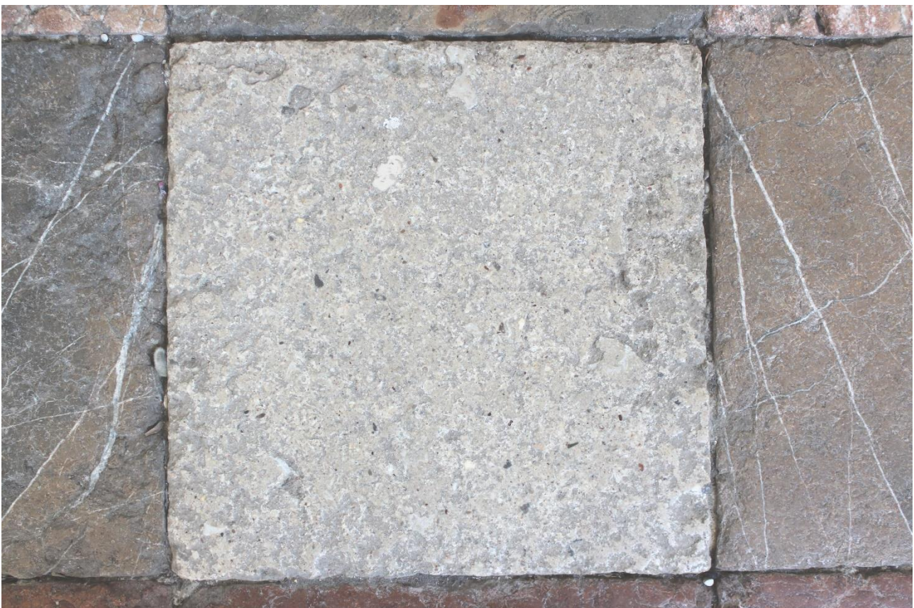
Abb. 13: Bodenplatte aus Untersberger Kalkstein, Größe der Platte. 42 x 42 cm (aufgenommen im Freisinger Dom: Kreuzgang).
