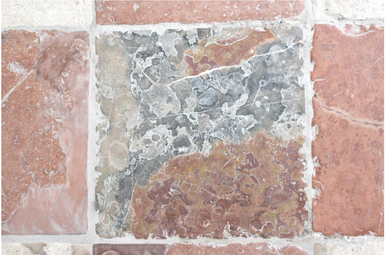
Abb. 6 Gelb-roter Knollenkalk mit grauen Bereichen, Größe der Platte: 43,5 x 43,5 cm (aufgenommen im Freisinger Dom: inneres nördliches Seitenschiff).
