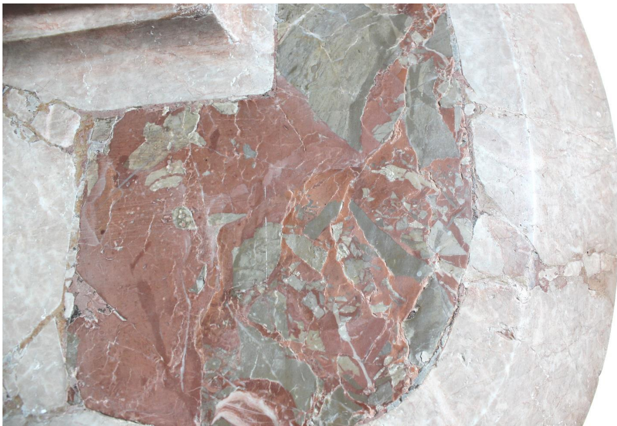
Abb. 23: Lithoklastischer rot-grauer Kalkstein, Bildbreite 30 cm (fotografiert im Freisinger Dom: Vorhalle).
