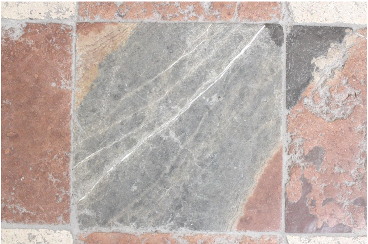
Abb. 4: Bodenplatte aus Rot-Grau-Schnöll, Größe der Platte: 43,5 x 43,5 cm (aufgenommen im Freisinger Dom: Vorhalle).
