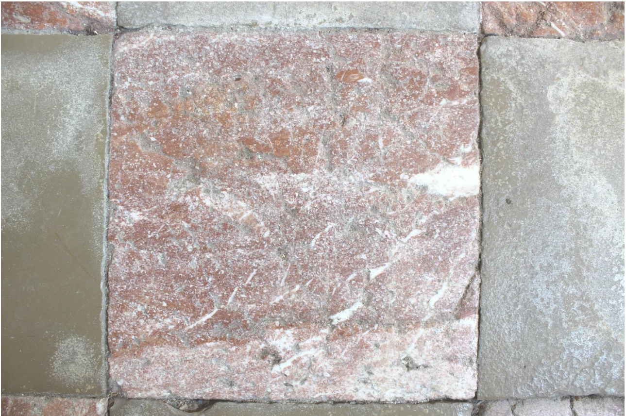
Abb. 7 Bodenplatte aus Hierlatzkalk, Größe der Platte: 42 x 42 cm (aufgenommen im Kreuzgang).
